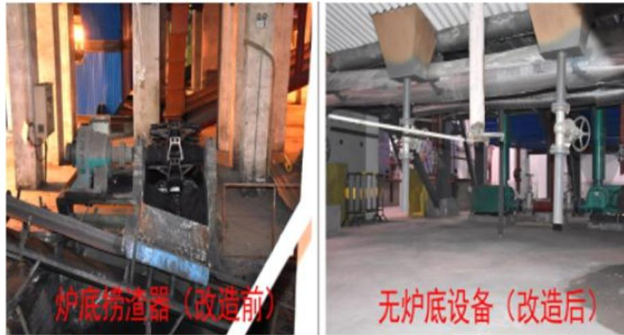
图 11: 项目改造前后除渣系统对比图
